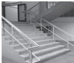
高等学校の階段では、<sup>ひき</sup>蹴上げが18 cm 以下、<sup>ふみ</sup>踏面が26 cm 以上となっており、この基準では、傾斜は最大で約35°である。
